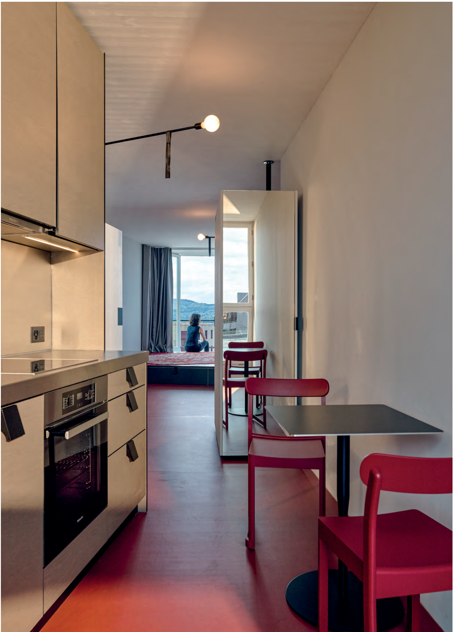
Die Vollholzwände sind mit Keimfarben bemalt, Linoleum bedeckt den Boden. An Metallprofilen und Autosicherheitsgurten lassen sich Wand, Schrank und Lampen drehen.
