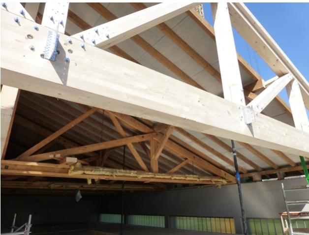
Alter und neuer Fachwerkbinder
