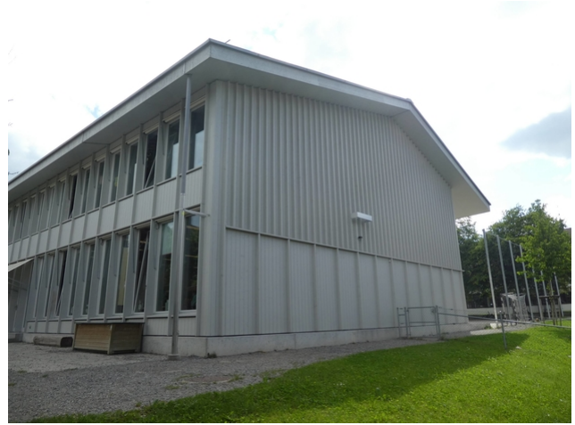
Fassade Ansicht Nord
