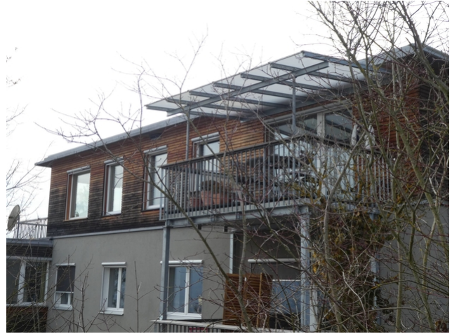
Fassade nach 10 Jahren
