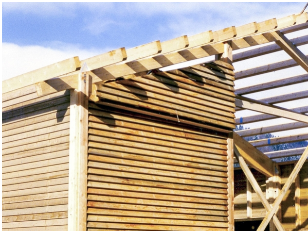
Montage der Wandelemente
