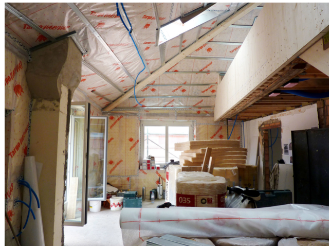
Wohnfläche bei der Renovierung
