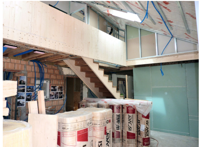
Küche während der Renovierung
