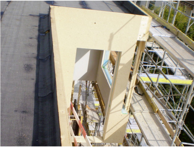
Surélévation du gros œuvre
