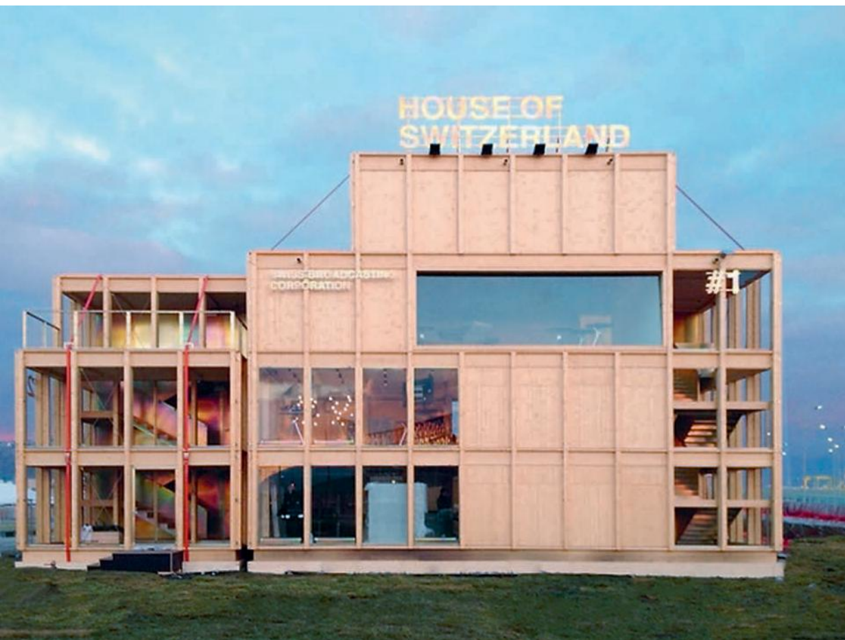
«House of Switzerland» : cette construction purement en bois n'a nécessité que quatre jours pour la mettre sur pied à Zurich
