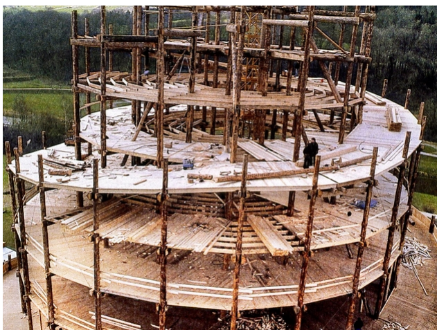
Turm im Rohbau
