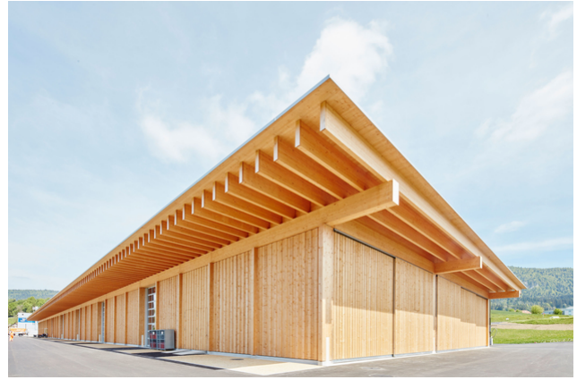
Kreuzweise gestapelte Tragkonstruktion: Die Dachbalken ruhen auf den Pfetten
