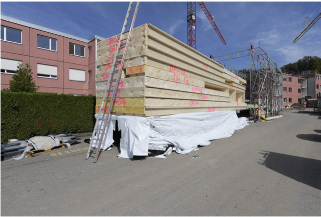
Lieferung der vorgefertigten Holzelemente
