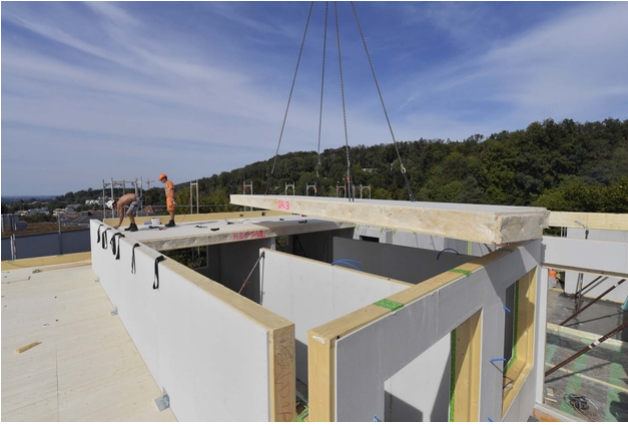
Aufrichtearbeiten mit dem Kran
