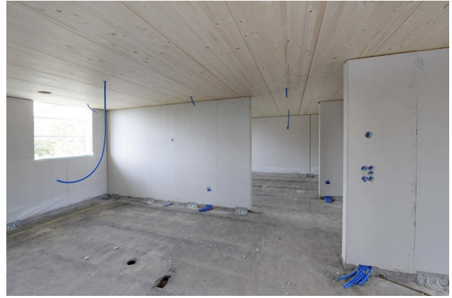
Innenansicht auf der Baustelle mit der Geschossdecke in Holz
