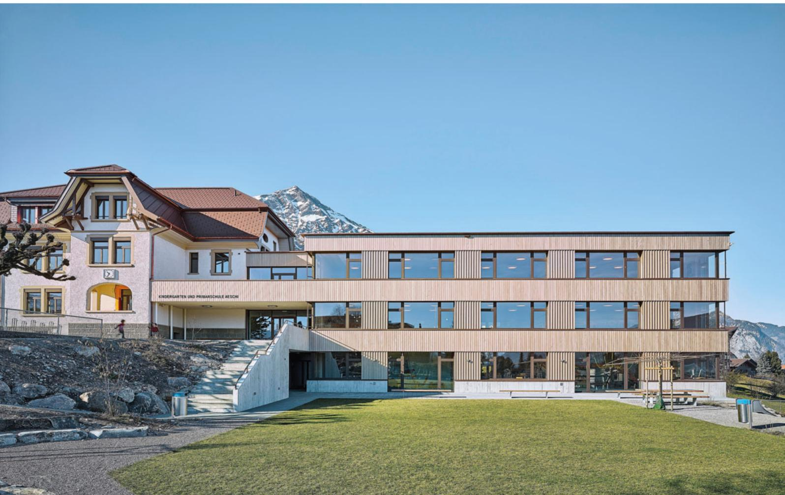
**Primarschulhaus Aeschi BE.** Für den Erweiterungsbau konnte Holz aus den gemeindeeigenen Wäldern eingesetzt werden. Aufbau in Holzmassiv- und Rahmenbauweise, Fassaden sind aus astfreien Tannenbrettern.
