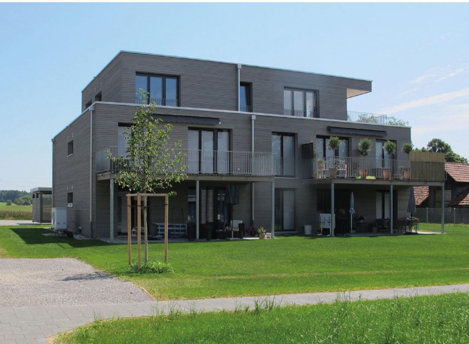
Wohnüberbauung Holleracher, Grossaffoltern. Auf betonierten Bodenplatten wurden vorgefertigte Holzelemente aufgerichtet. 13 x 2,5 Meter grosse Brettschichtholzplatten wurden auf der Baustelle stirnseitig verklebt und bildeten so die Geschossdecken.
