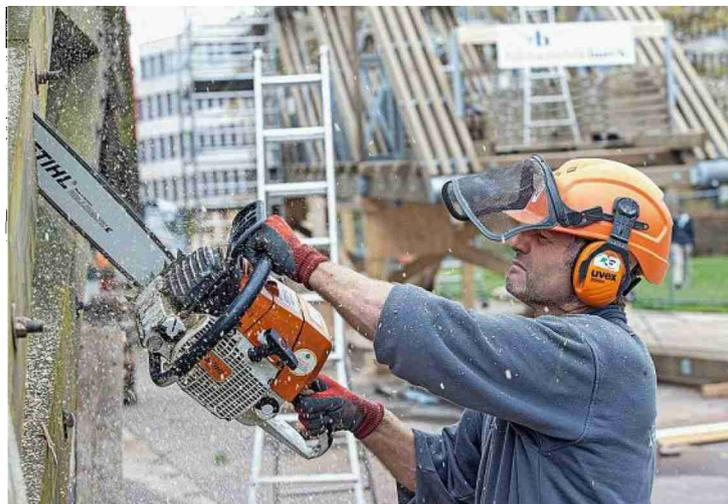
Nach der Demontage wurde die alte Brücke mit Motorsägen in Einzelteile zerlegt und abtransportiert. Foto: Patrick Gutenberg
