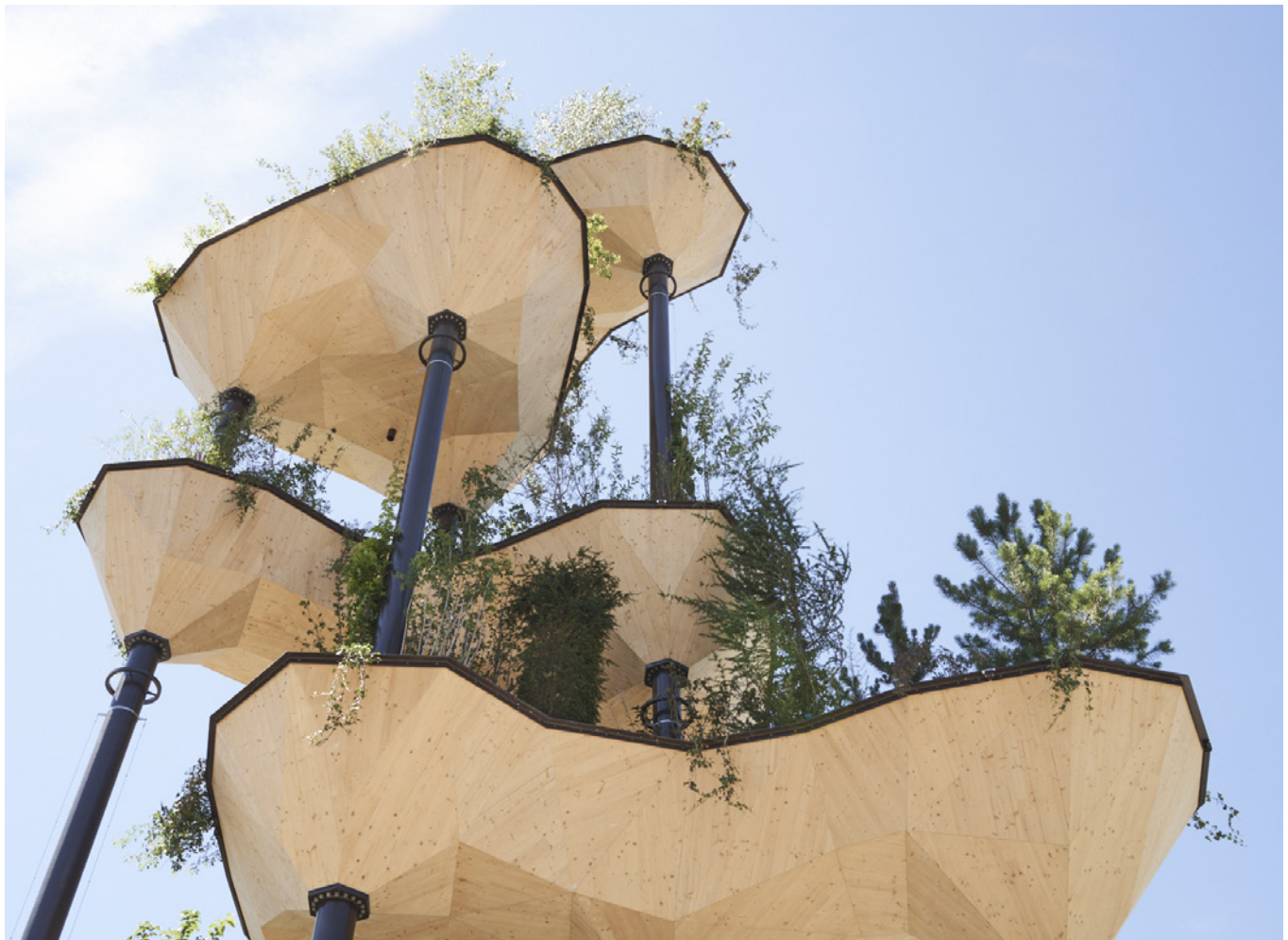
Brettsperrholzplatten wie bei der Skulptur Semiramis in Zug können bald aus Scrimber-Produkten hergestellt werden.
