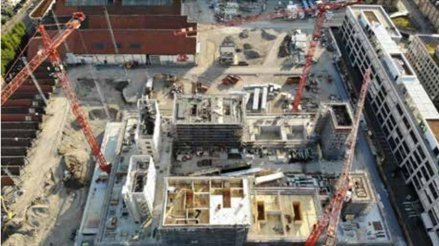
Bild 15: Luftbild der Holzbaumontage. Gut sichtbar: Der vormontierte Holzbau zur Ausbildung der Treppenhäuser (Bildquelle: Implenia)
