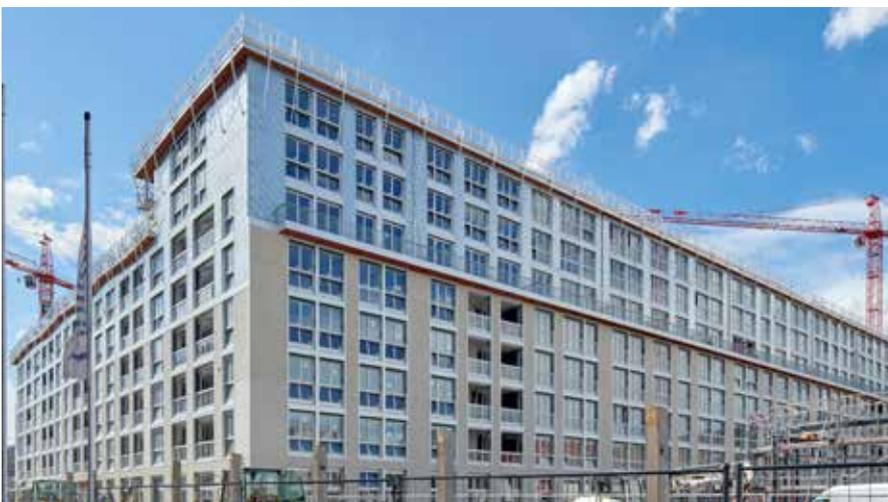
Bild 17: Gegenüber dem Dialogplatz ist das „Krokodil“ acht Geschosse hoch. Die klar strukturierte Fassade erhielt Bekleidungen aus Glasfaserbeton im unteren und Schindeln aus Titanzink im oberen Teil. (Bildquelle: Gesewo – zimmermannfotografie)
