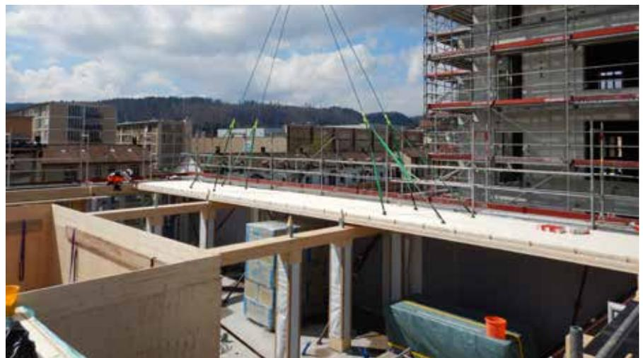
Bild 13: Die bis zu 19 m langen BSP-Elemente werden als Durchlaufträger über die BS-Holz-Träger verlegt. Stahlstifte mit pyramidenförmigen Spitzen sorgen dafür, dass sich die Platten einfach auf den Stahlrohren einfädeln lassen. (Bildquelle: Implenia – Alessandro Della Bella)
