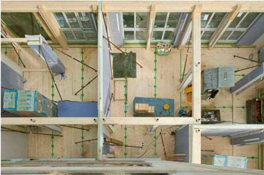
Bild 10: Von oben auf das Holzskelett geschaut: Die BS-Holz-Unterzüge fädeln über Stützenköpfe aus Stahl zur Kraftdurchleitung auf den BS-Holz-Stützen ein. (Bildquelle: Gesewo – zimmermannfotografie)
