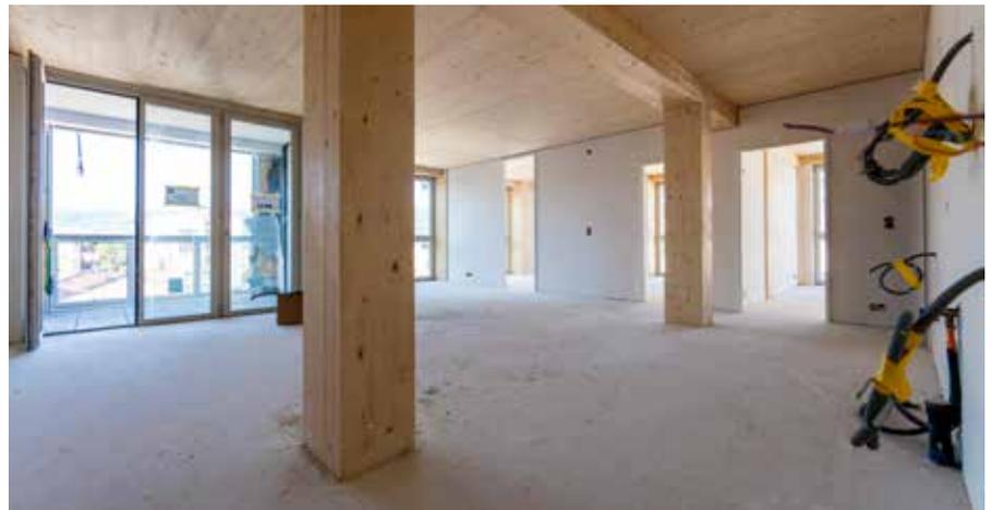
Bild 8: Das Tragwerk aus BS-Holz-Stützen und -Trägern sowie BSP-Decken bleibt sichtbar ... (Bildquelle: Implenia – Alessandro Della Bella)
