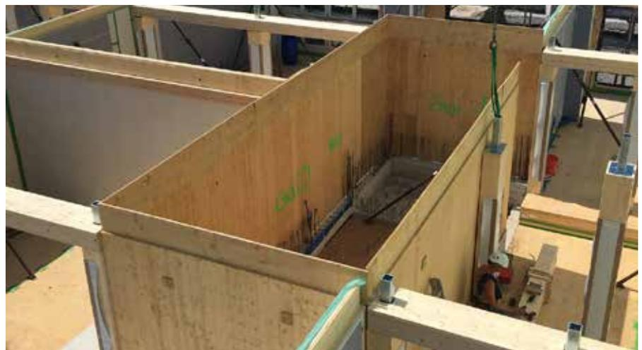
Bild 14: Umkehrung des Bauprozesses: Zuerst wurden die Geschosse in Holz aufgerichtet. Parallel dazu wächst die verlorene Schalung aus 42 mm dicken Dreischichtplatten für den Treppenhausschacht mit in die Höhe. (Bildquelle: Baumberger & Stegmeier Architekten)
