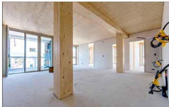
Die Holzstützen des Skelettbau bilden mit ihrem Raster von 3 x 4 m einen prägenden Teil der Architektur. Die Fensteröffnungen sind bodentieft angelegt (französische Fenster mit vorgesetzten Brüstungen) und paarweise vertikal zusammengefasst.
