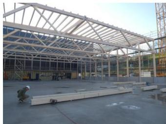
Figure 17 : Réalisation des fermes
