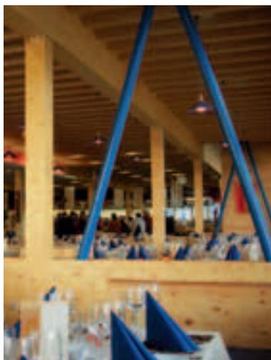
Verbände eingeleitet. Das Untergeschoss wird durch ein Zugstabsystem ausgesteift. Im Erdgeschoss werden die Kräfte durch Strebenböcke aus Stahlrohren aufgenommen. Zur Wind- und Erdbebenaussteifung wird zusätzlich der in
