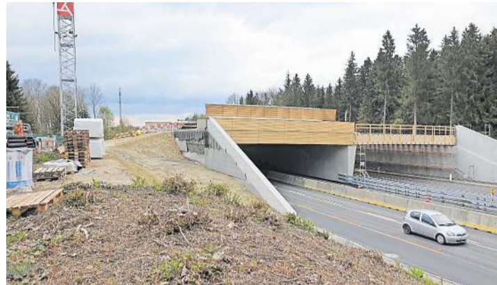
Die Passage für Tiere über die Autobahn von nahe betrachtet. Viel Fichtenholz aus dem Entlebuch wurde verbaut. Bild: mma
